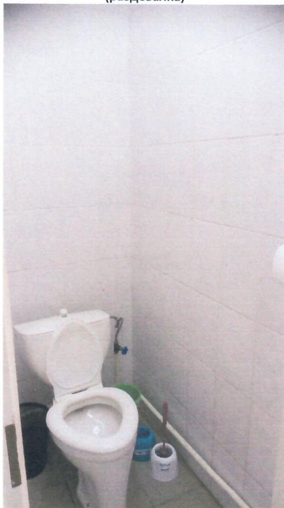
Фото № 23 Туалетная комната (раздевалка)
