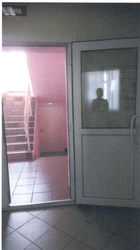
Фото № 13 Дверь, вход на лестницу
