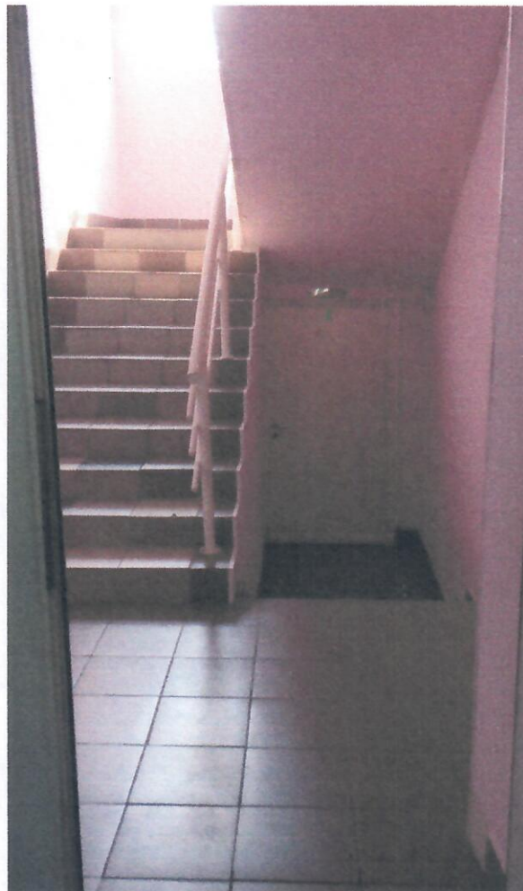
Фото № 26 Пути эвакуации
