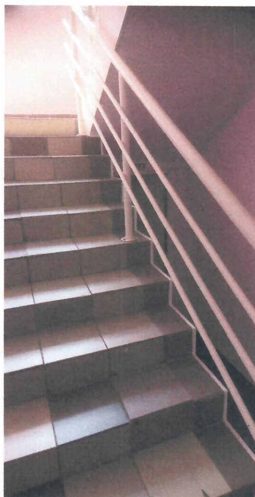
Фото № 14 Лестница (внутри здания)
