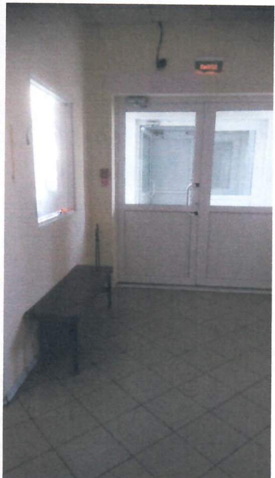
Фото № 8 Дверь (входная)
