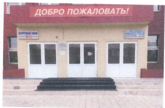
Фото № 3 Лестница (наружная)
