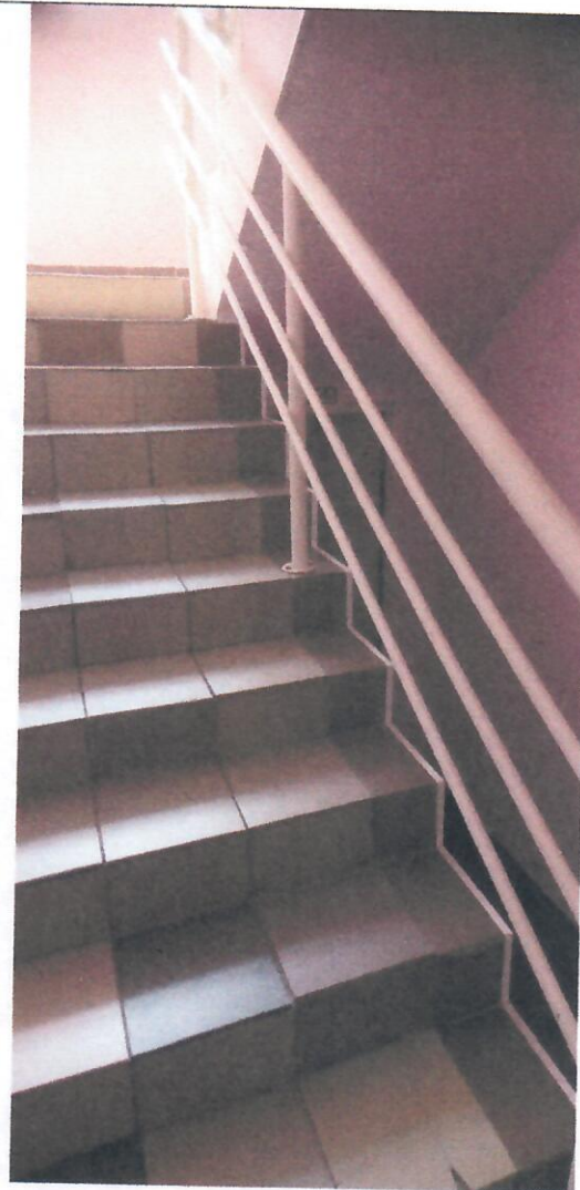
Фото № 13 Лестница (внутри здания)
